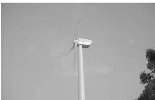
風力発電装置
